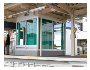
ホーム上に完成したエレベーター
