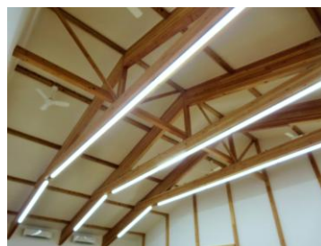
天井が高く広い多目的室
