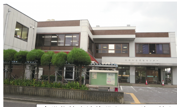
多世代等交流施設として建て替えとなる予定の老人福祉センター
