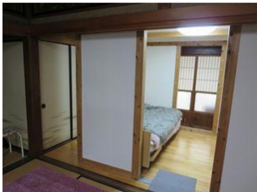
6畳間の中に作られた耐震シェルターの施工例
