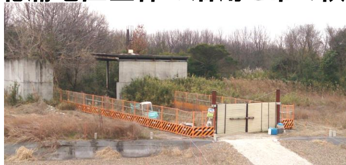
建設予定地にある民間業者の産廃焼却炉
