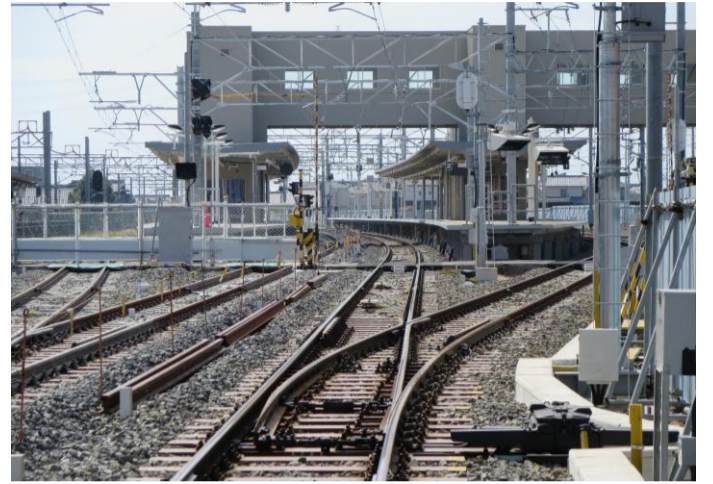
下り仮線路、布袋駅仮連絡通路
