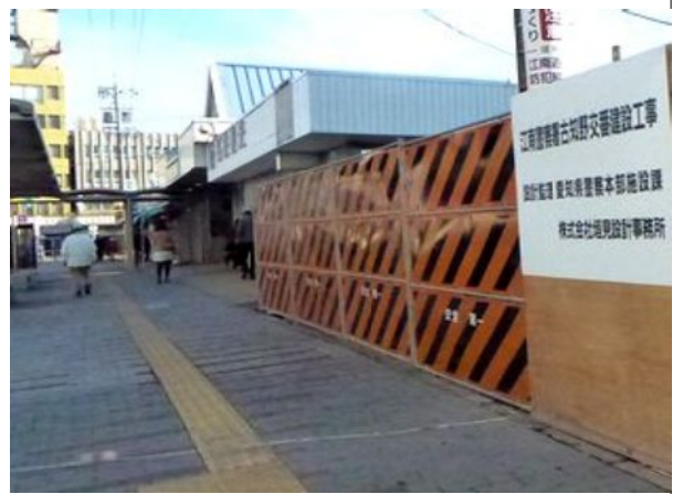
工事中の江南駅前の古知野交番
