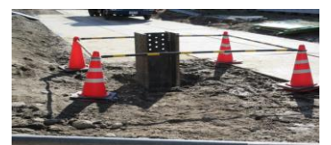
8m埋めた基礎の鉄杭
