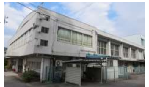
解体が計画されている古知野北公民館(築54年)
