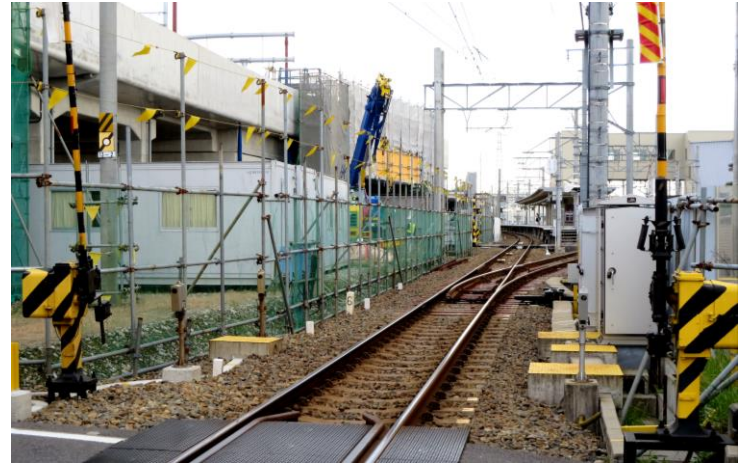
犬山方面の高架工事が大幅に遅れています
